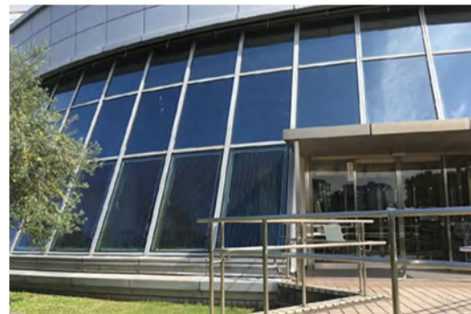
見学設備の窓には薄膜太陽電池を設置
